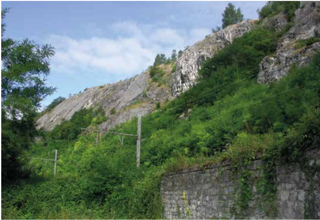
Abb. 37: Die Robinie wird häufig an Bahngleisen angepflanzt, um die Böschungen zu stabilisieren und die Bodenerosion zu verringern. Über Wurzeltrieb Bildung, Stockausschlag und Samenerzeugung breitet sie sich ausgehend von ihrem Anpflanzungsstandort rasch aus und kann in benachbarte natürliche Habitate, wie beispielsweise die felsige Umgebung in diesem Bild, eindringen. Für die Vermeidung von Bodenerosion sollte die Robinie möglichst durch andere heimische Pflanzen ersetzt werden, von denen man weiß, dass sie Bodenerosion verhindern [Foto: E. Branquart].
